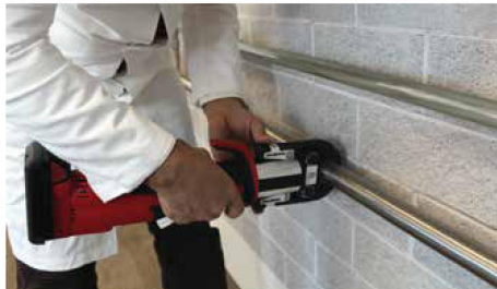
Herstellen der Pressverbindung Bild Nr. 18
