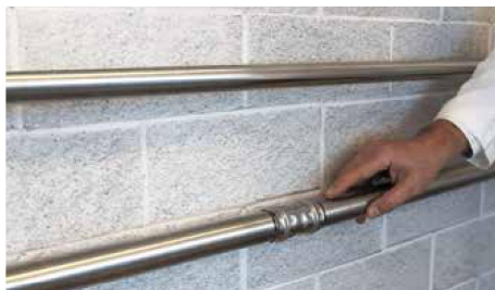
Kontrolle der Pressverbindung Bild Nr. 19
