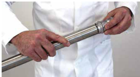
Einführen des Rohres in den Pressfitting Bild Nr. 17
