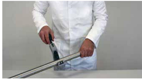
Ablängen des Leitungsrohres
